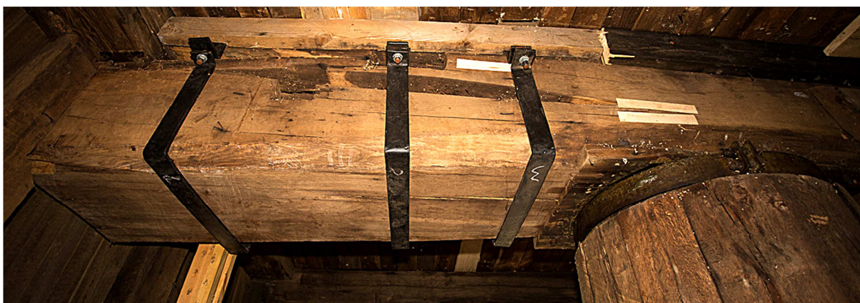
Fot.9. Złamana mącznica od strony nawietrznej. W szczelinę można swobodnie wsunąć dłoń. Fot. Marek Kowalczyk 2016-08-19
