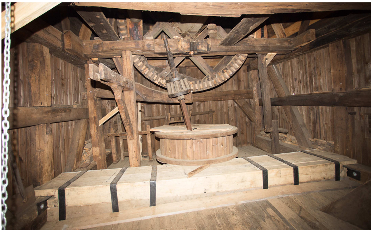
Fot.10. Czopy sztogu wysunęły się z gniazd – jest prowizorycznie podparta. Poniżej drewniane wzmocnienia złamanej mącznicy połączone z nią stalowymi strzemionami. Łubie uniesione i oparte na wzmocnieniu mącznicy. Cewie wysprężone po wyjęciu sochy z łożyska.
