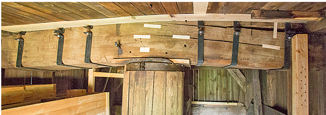
Fot.7. Złamana mącznica od strony zawietrznej. W szczeliny po prawej stronie można wsunąć dłoń. Fot. Marek Kowalczyk 2016-08-19
