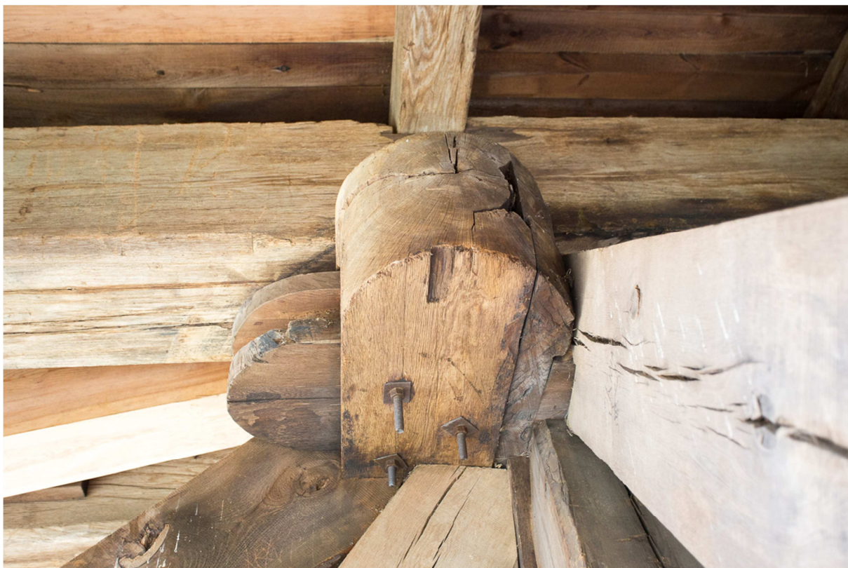
Fot.5. Pęknięte siodło.
