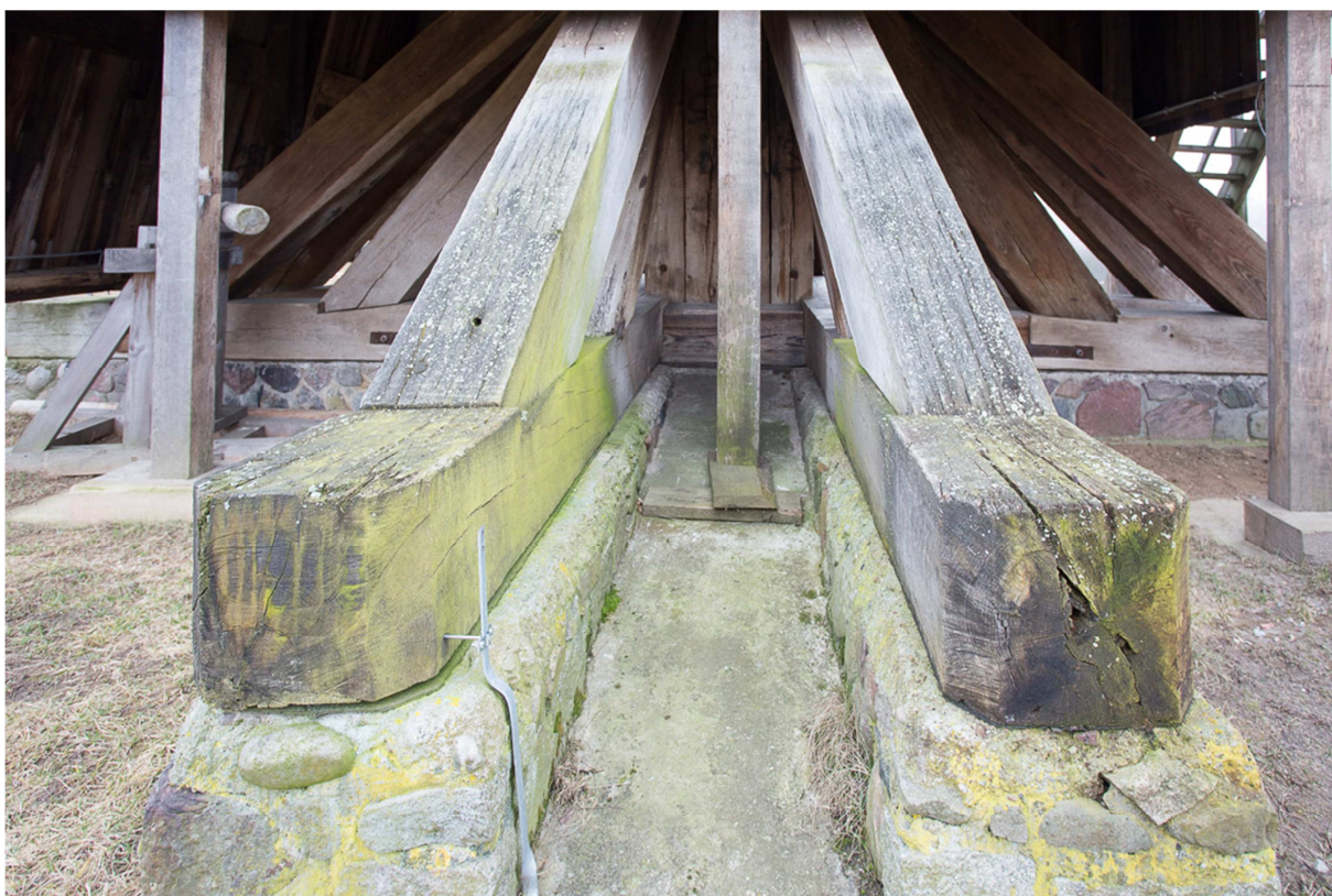
Fot.6. Korozja biologiczna podwalin i zastrzałów. Wiatrak jest tymczasowo podparty stemplami.
