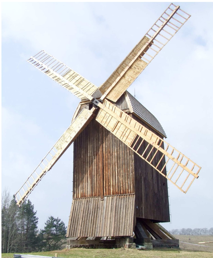
Fot.1. Wiatrak po remoncie. Film z tego dnia ukazuje skrzydła obracające się w niewłaściwą stronę – wiatrak jest ustawiony tyłem do kierunku wiatru (niebezpieczne dla mechanizmów).
