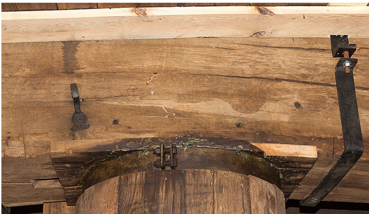
Fot.8. Złamana mącznica od strony zawietrznej. Zbliżenie rozerwanych włókien w punkcie podparcia. Fot. Marek Kowalczyk 2016-02-13
